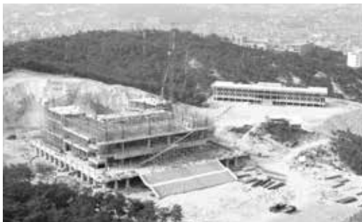
국립극장과 국립국악원 공사 현장(1968. 9. 14 / 사진 제공. 국가기록원)
